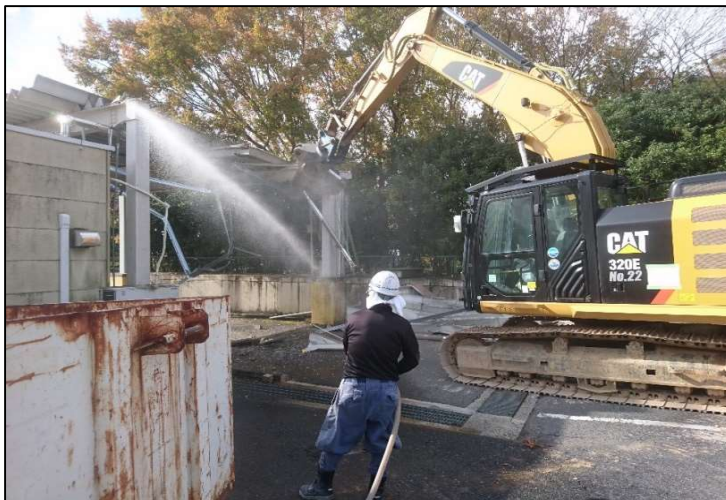
旧計量棟の解体状況
