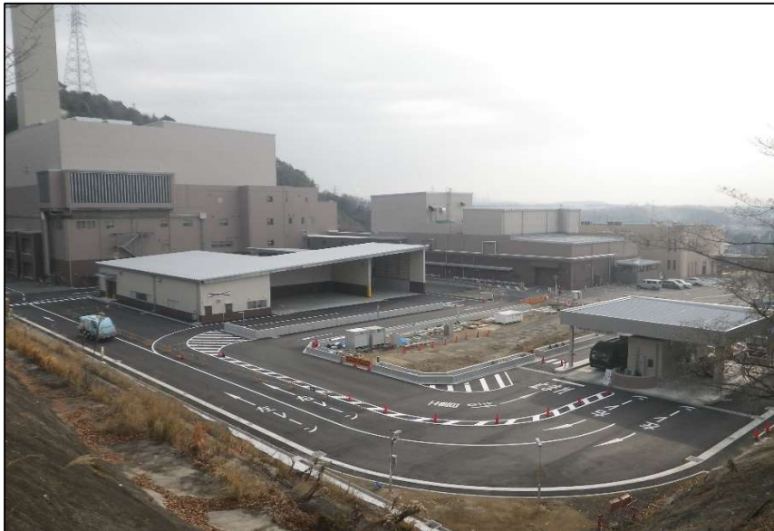
北西角からの全景
