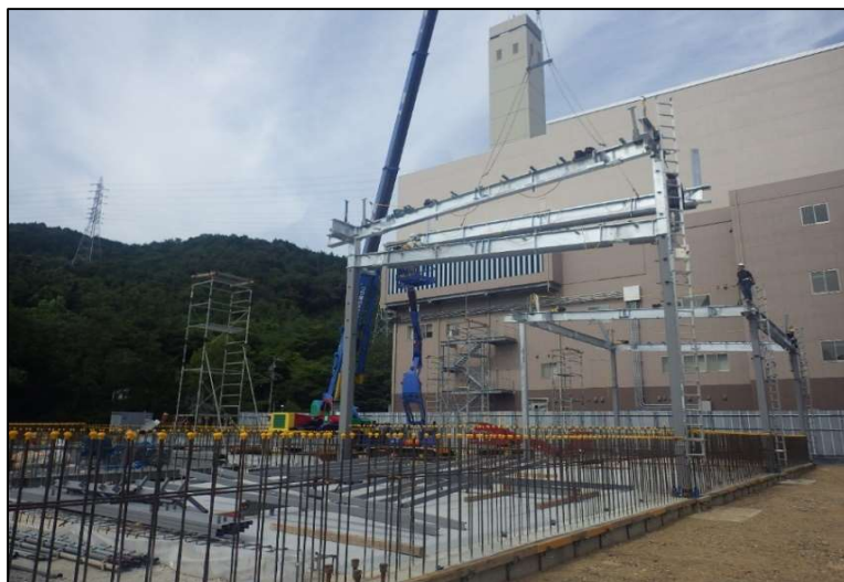
ストックヤードの鉄骨工事状況
