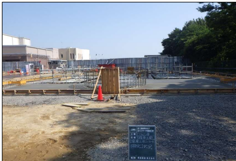
計量棟の土間コンクリート打設完了状況
