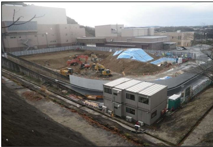
解体作業状況(北西角より)
