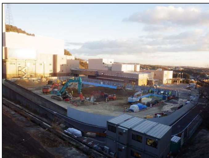
解体作業状況(北西角より)
