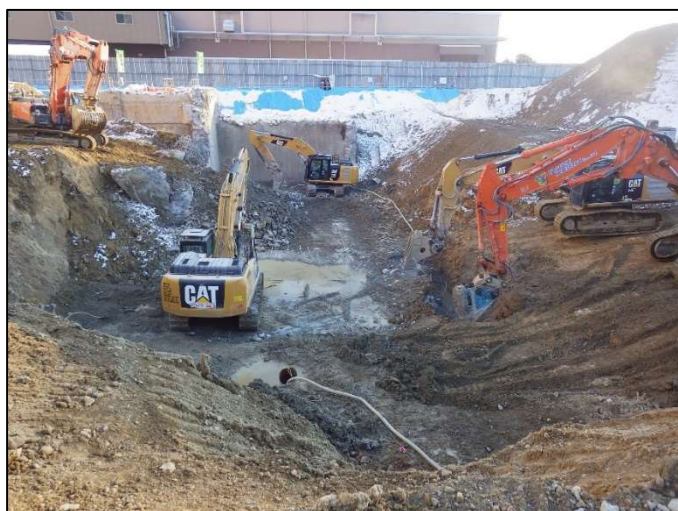
ごみピット底のコンクリートの解体作業状況
