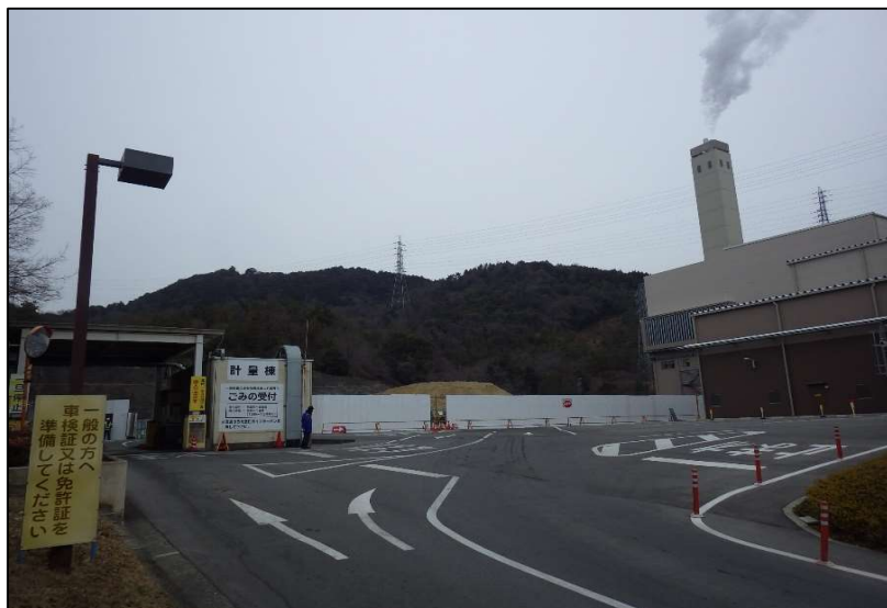
南面の作業状況
